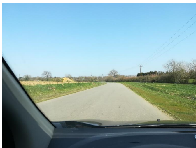
Figure n°101. Voie longeant le site du projet
